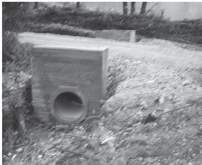
Rekonštrukcia protipožiarnej lesnej cesty „Diel“
