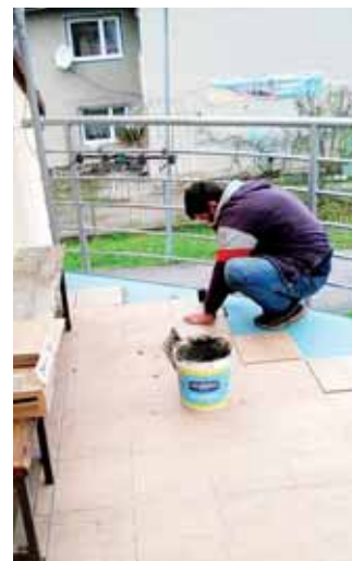
Pokládka dlažby v HZ
