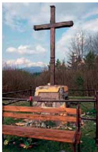
Osadenie dočasného kríža
