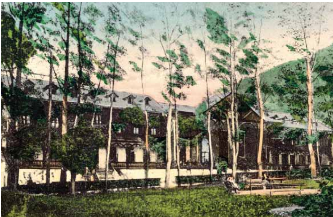
Pohľad na predné priečelie pavilónu Lajos (Ludvik, Ďumbier) na farebnej kolorovanej pohľadnici zo začiatku 20. rokov 20. storočia, ktorá je pisateľom datovaná na 24. júla 1924
